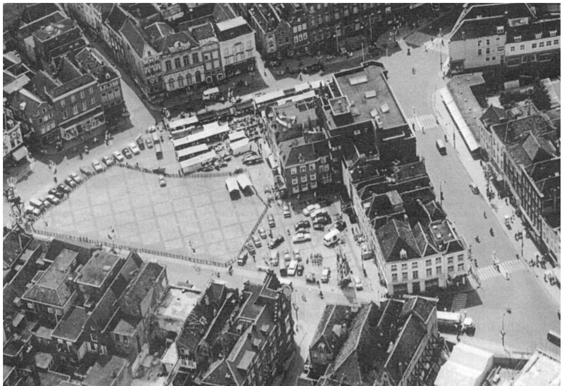
Situatie na de reconstructie van 1953.
