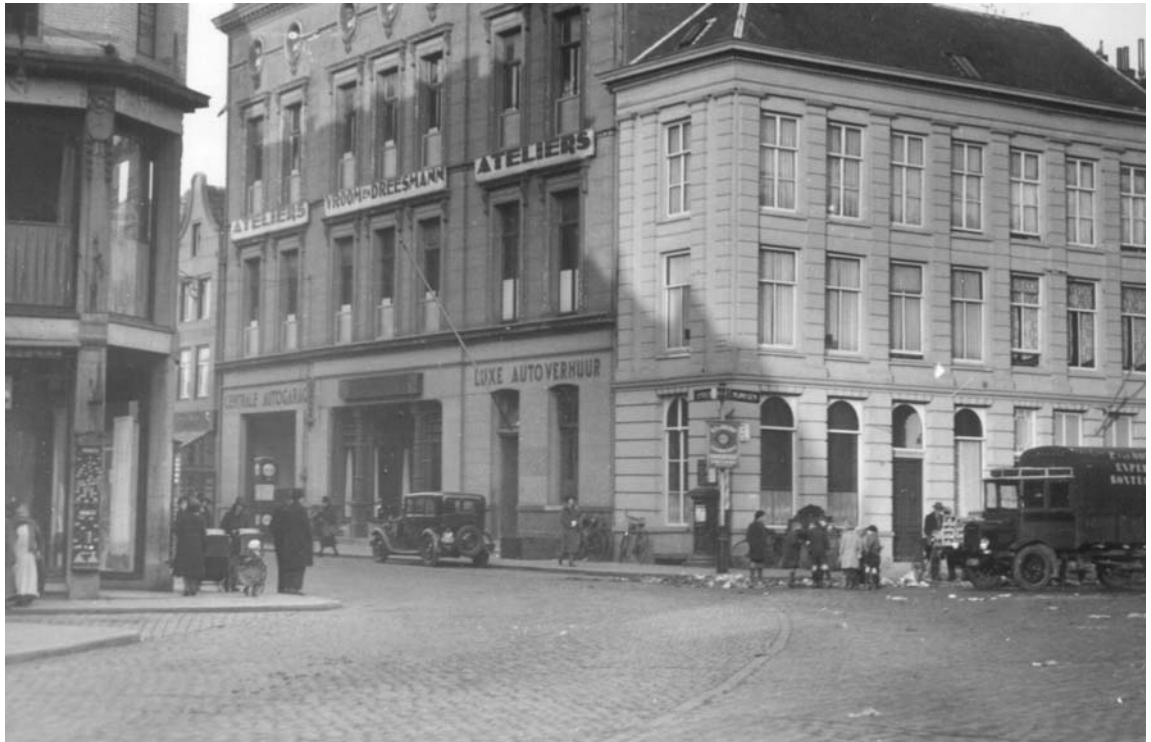
Hoek Pensmarkt - Markt rond de eeuwwisseling. Tussen de rijbaan van de Pensmarkt en de Markt is alleen een 'visuele' afscheiding in de vorm van een band aanwezig. Deze band ligt op dezelfde hoogte als de omringende kinderkopjes.
